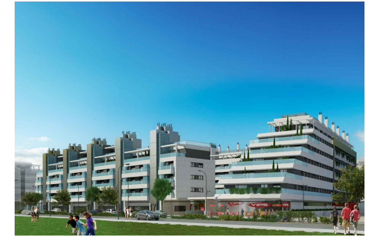
AV COMANDANTE JOSE MANUEL RIPOLLÉS (Edificio singular frente al Corte Inglés de Getafe)
